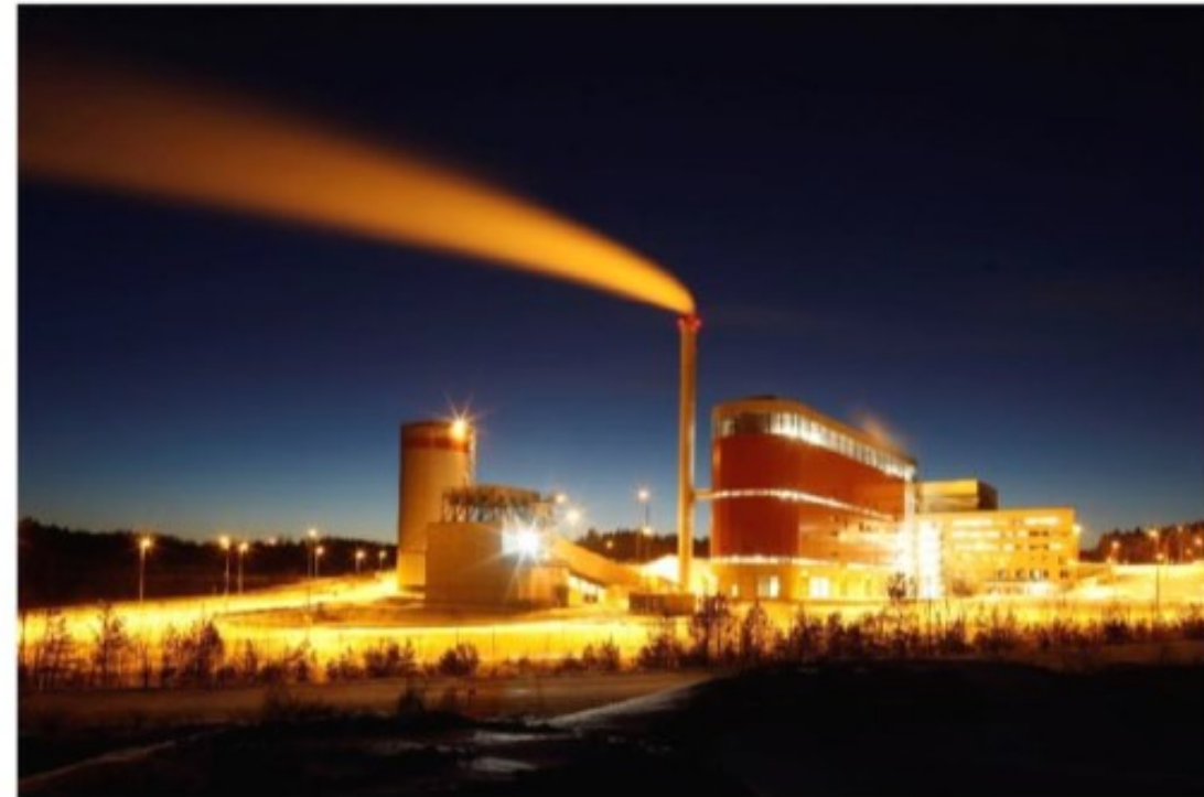
Uddevalla WtE plant, Sweden
